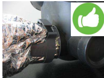
Raccordements correctement réalisés avec colliers de serrage
