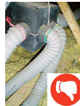
Raccordements mal réalisés avec risque de débranchement
