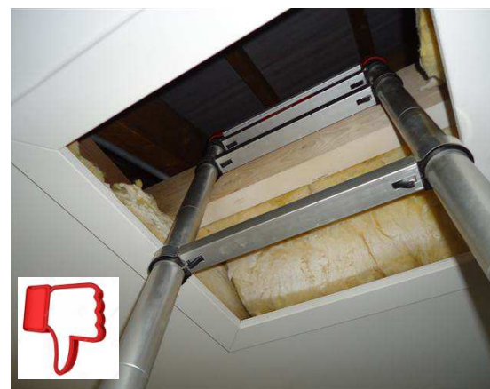
Trappe d'accès encombrée et passage réduit
